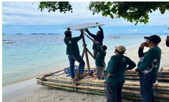
Gambar 2. Praktik Perakitan Panel Surya dan Lacuda pada Rumpon
