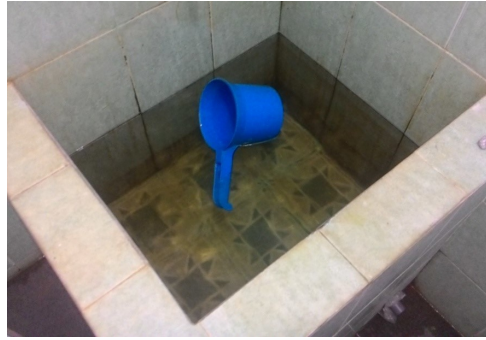
Gambar 1. Bak Penampungan air
